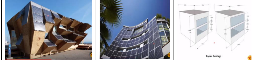
الشكل رقم (21): جدران خلايا شمسية ذات أشكال تتماشى مع الأسطح المعرضة لأشعة الشمس، المصدر: (Krawietz, 2011)
