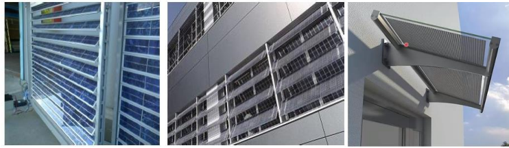
الشكل رقم (22): نماذج لمانعات الشمس، المصدر: (Krawietz, 2011)
