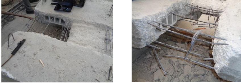
الشكل رقم (27) إجراء التخریب الافتراضي للبلاطة
