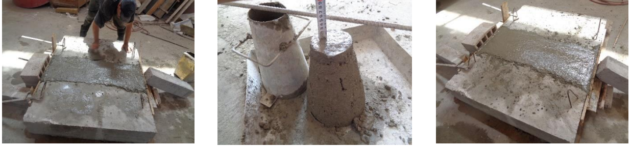
الشكل رقم (29): عملية الكوفراج والصب والصل
