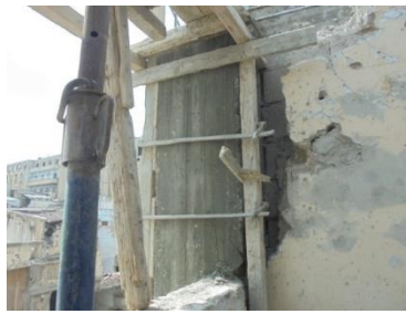
الشكل رقم (15): وضع الكوفراج الخشبي للفجوة الثانية مع الجائز الحامل
