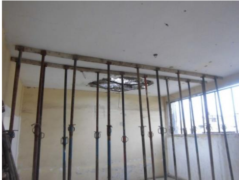
الشكل رقم (11): الفجوة في السطح الاخير لمدرسة سعيد العاص
