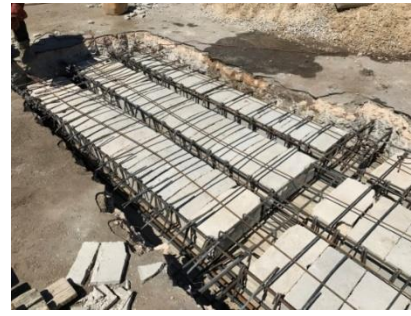
الشكل رقم (16): فرش الهوردي وتنفيذ تسليح الأعصاب وشبكات التسليح وأعمال اللحام الكهربائي
