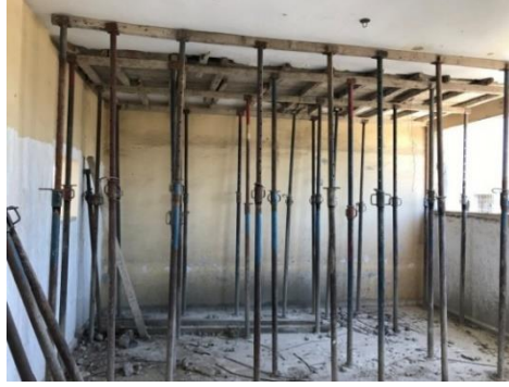
الشكل رقم (14): وضع الكوفراج الخشبي للفجوة الأولى
