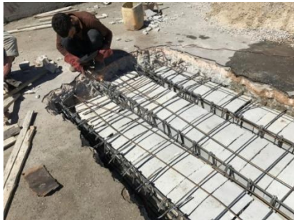
الشكل رقم (16): فرش الهوردي وتنفيذ تسليح الأعصاب وشبكات التسليح وأعمال اللحام الكهربائي
