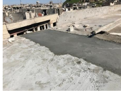
الشكل رقم (17): عملية صب البيتون في الفجوة
