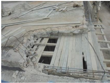
الشكل رقم (15): وضع الكوفراج الخشبي للفجوة الثانية مع الجائز الحامل
