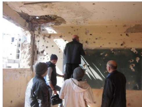
الشكل رقم (11): الفجوة في السطح الاخير لمدرسة سعيد العاص
