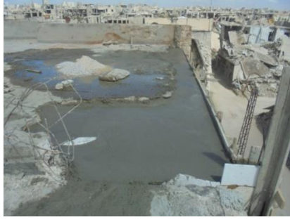
الشكل رقم (17): عملية صب البيتون في الفجوة
