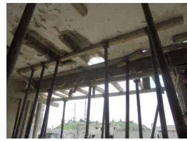
الشكل رقم (15): وضع الكوفراج الخشبي للفجوة الثانية مع الجائز الحامل
