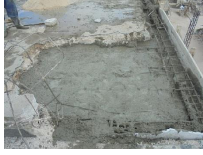
الشكل رقم (17): عملية صب البيتون في الفجوة
