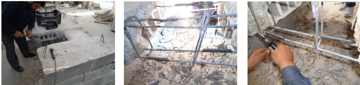
الشكل رقم (28): إصلاح القضبان الفولاذية المتضررة
