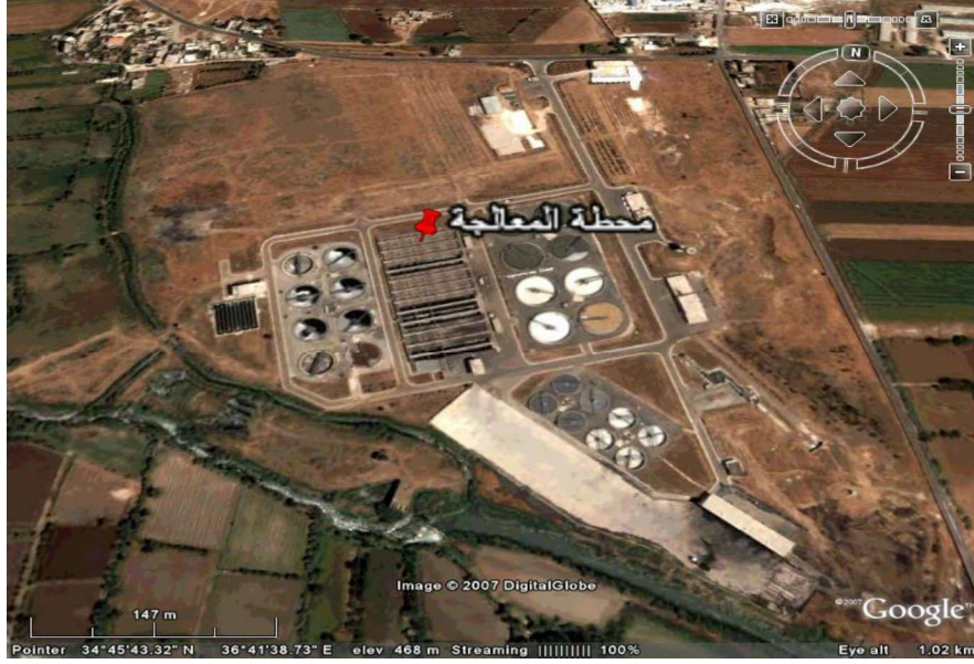
الشكل رقم (3): يوضح صورة جوية لمحطة معالجة مياه مجاري مدينة حمص
