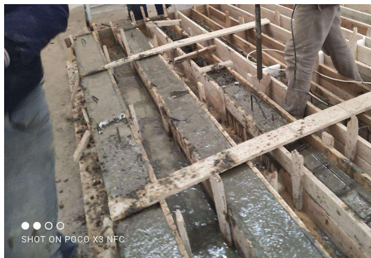
الشكل رقم (3): الجوائز المصبوبة بمخبر كلية الهندسة المدنية-جامعة حمص
