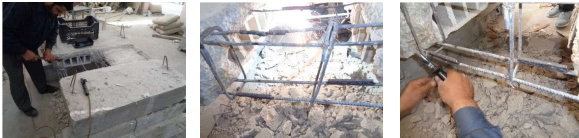
الشكل رقم (28): إصلاح القضبان الفولاذية المتضررة
