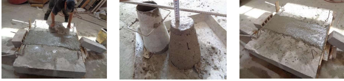
الشكل رقم (29): عملية الكوفراج والصب والصل
