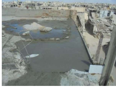
الشكل رقم (17): عملية صب البيتون في الفجوة
