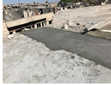
الشكل رقم (17): عملية صب البيتون في الفجوة
