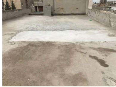
الشكل رقم (17): عملية صب البيتون في الفجوة
