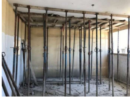
الشكل رقم (14): وضع الكوفراج الخشبي للفجوة الأولى
