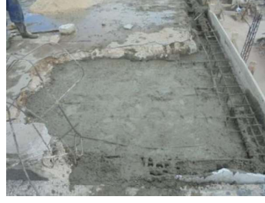
الشكل رقم (17): عملية صب البيتون في الفجوة
