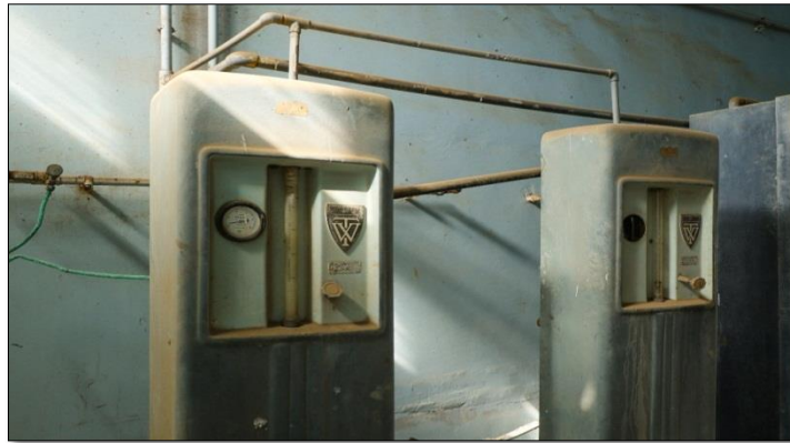
الشكل رقم (7): أجهزة غاز الكلور النهائية
