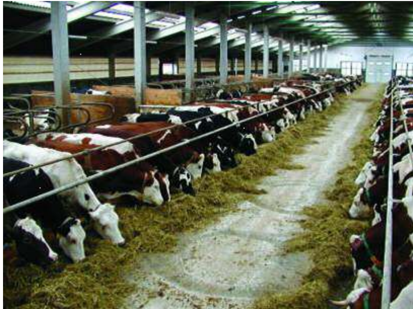
حظيرة مغلقة ذات مرابط بصفين وجها لوجه يفصلهما ممر التغذية
