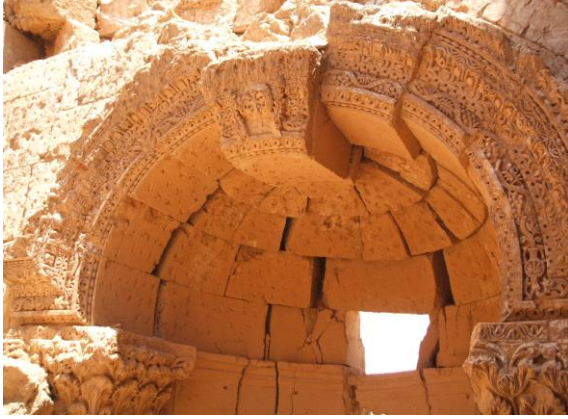
تدلي حجر القفل نتيجة القوى الأفقية بعد انهيار و تضعضع المسند الخارجي
