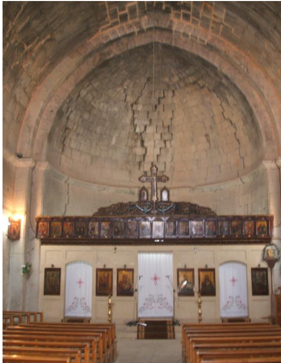
التشققات و انفتاح الجدران نتيجة القوى الأفقية الناتجة عن حملات السقف في برج صافيتا
