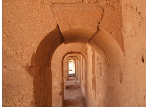
تدلي حجر القفل نتيجة القوى الأفقية بعد انهيار و تضعضع المسند الخارجي
