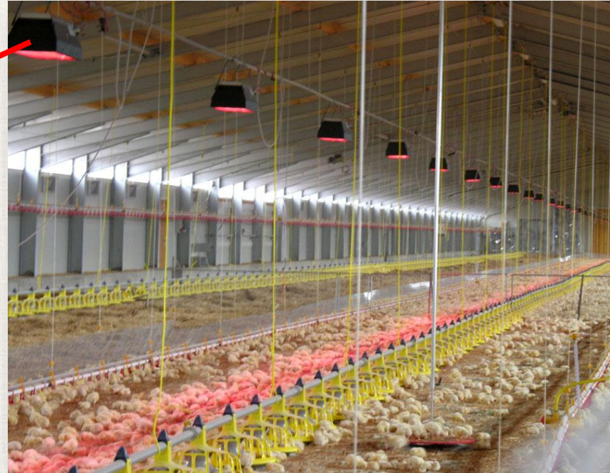
تدفئة قسم التحضين بمشعات الأشعة تحت الحمراء الكهربائية
