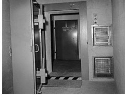
الشكل رقم (4): مدخل أحد المخابئ المضادة للإشعاعات النووية في سويسرا
