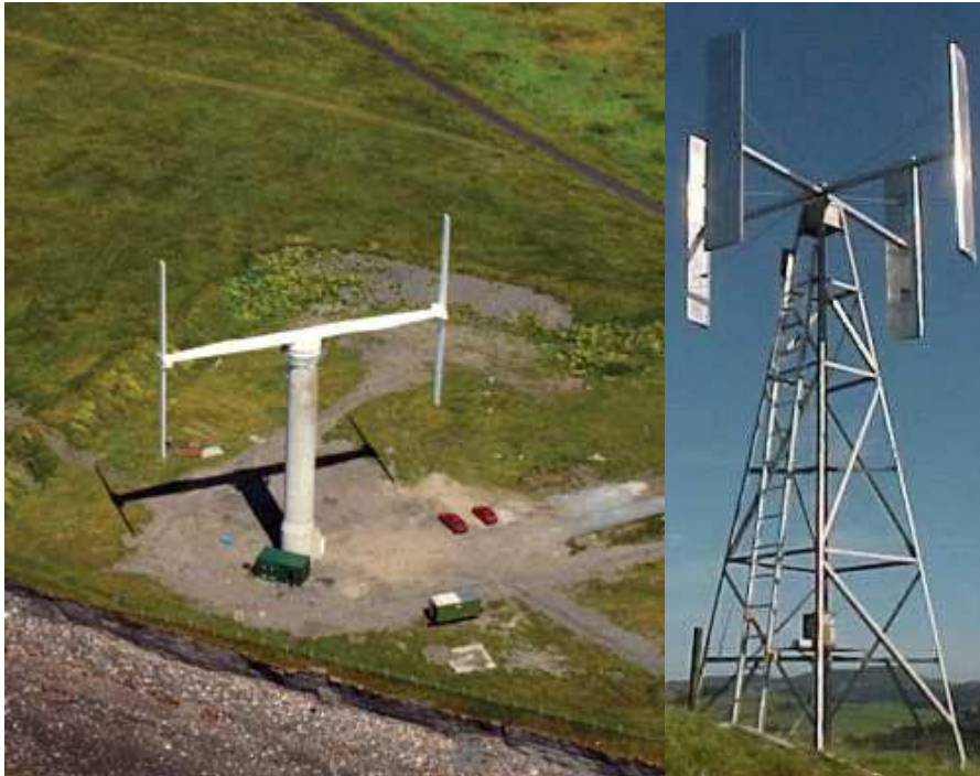
الشكل (٢-٤) عنفة H-Rotor ذات الشفرات المستقيمة الثابتة
